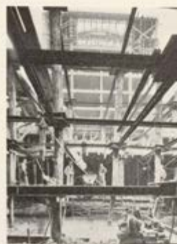
Vue verticale de l'ossature et du blindage de la fouille.
