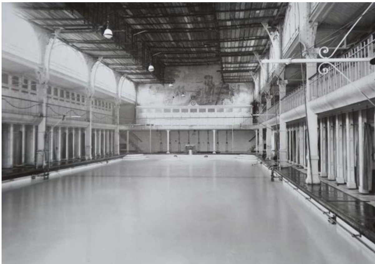
Gemeentelijk zwembad van Sint-Gillis. Door problemen van corrosie van de metalen structuur, maar misschien ook van verwarming, moest een houten plafond worden geplaatst.
