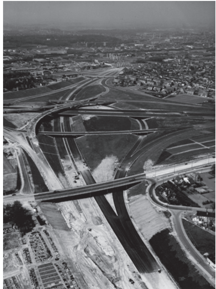
Door de aanleg van de verkeersring rond Brussel werden de randgemeenten ontsloten. Foto van de ingrijpende werkzaamheden voor de bouw van R0-ringweg, Machelen, april 1975 [BE ADVN AC453 - Archief Vlaamse Toeristenbond/Vlaamse Automobilistenbond (VTB/VAB)]
